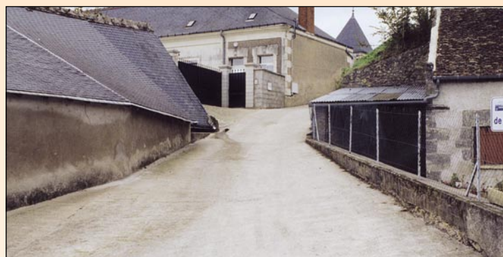
▲ Chaussée en V pour mener les eaux de ruissellement à un collecteur.
