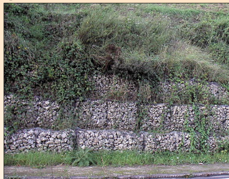
▲ Gabion en stabilisation de pied de talus
