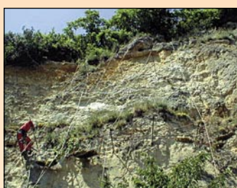
◀ Pose d'écran de protection à mi-paroi
