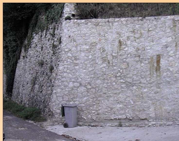
▲ Mur de soutènement restauré
